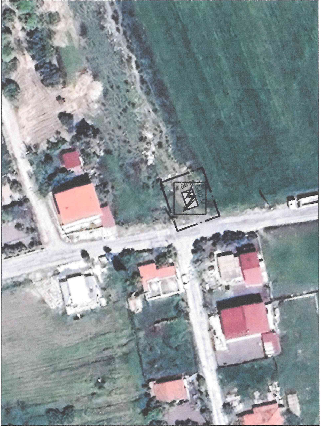
-Trafo Alanının Uydu Görüntüsündeki Konumu-
